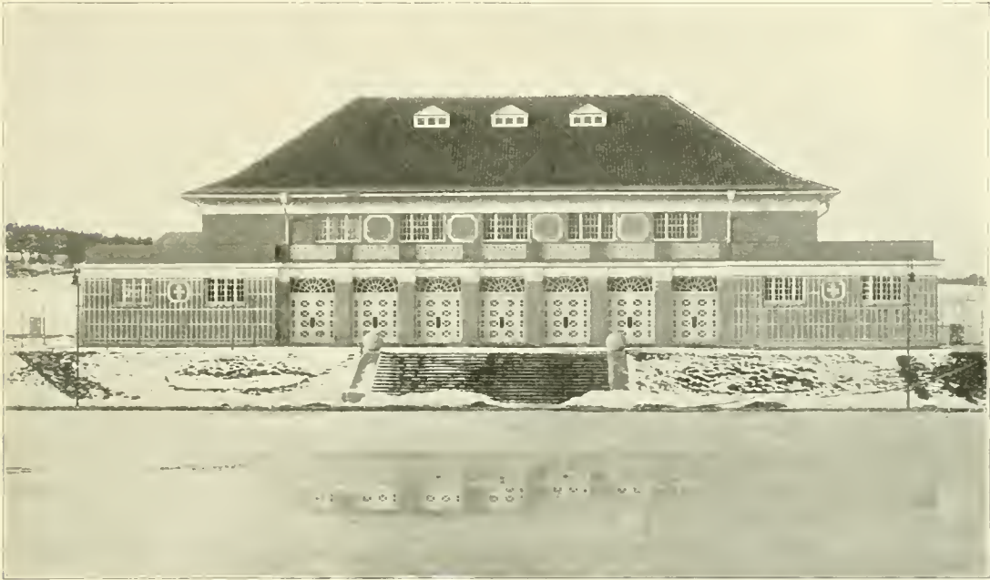
P. Bonatz und F. E. Scholer, Turnhalle in Feuerbach
