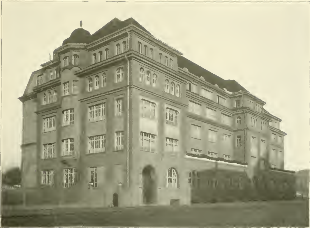
Schmohl & Staehelin, Fabrik Teufel in Stuttgart
