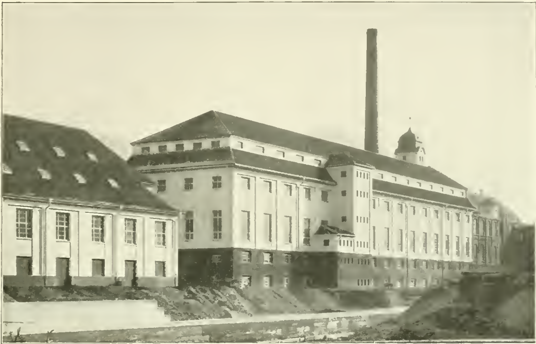
L. Eisenlohr, Papierfabrik Scheufelen, Oberlenningen
