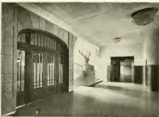
Lambert & Stahl, Haus der Ersten Kammer (Korridor) aus: „Architektur des XX. Jahrhunderts“, Berlin, Wasmuth & Co.
