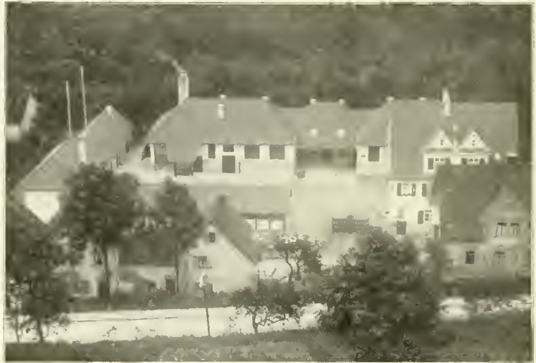
Jos. Hennings, Schlachthofanlage in Oberndorf a. N.
