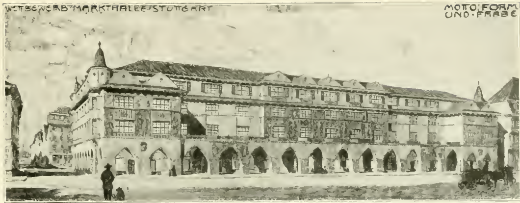
M. Elsaßer, Neue Markthalle in Stuttgart
